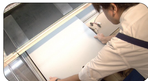
ショーケースの床板をはずします。
