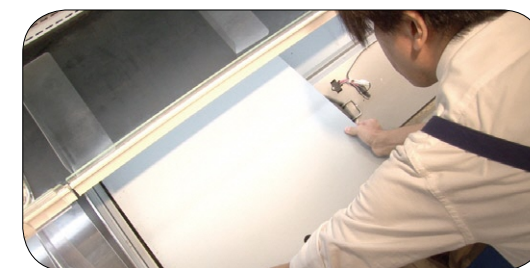
床板を外します
